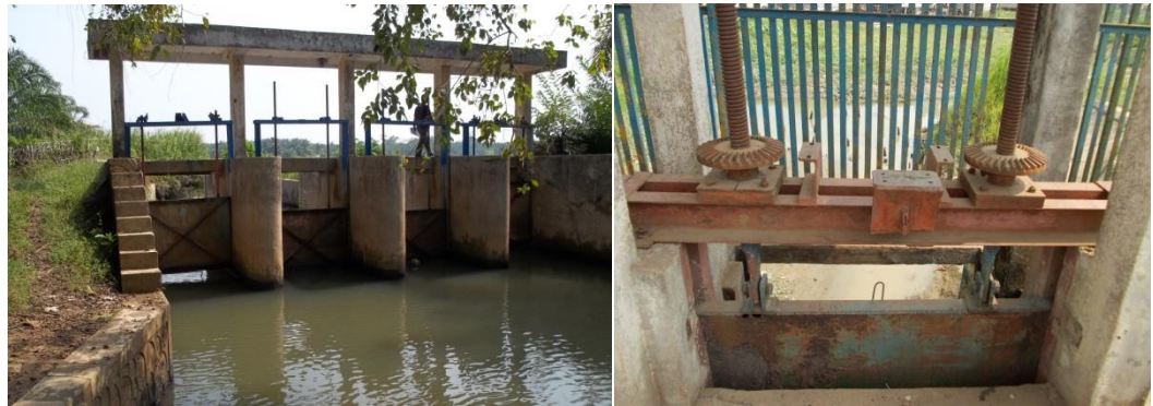
Gambar 4 Pintu skot balok
